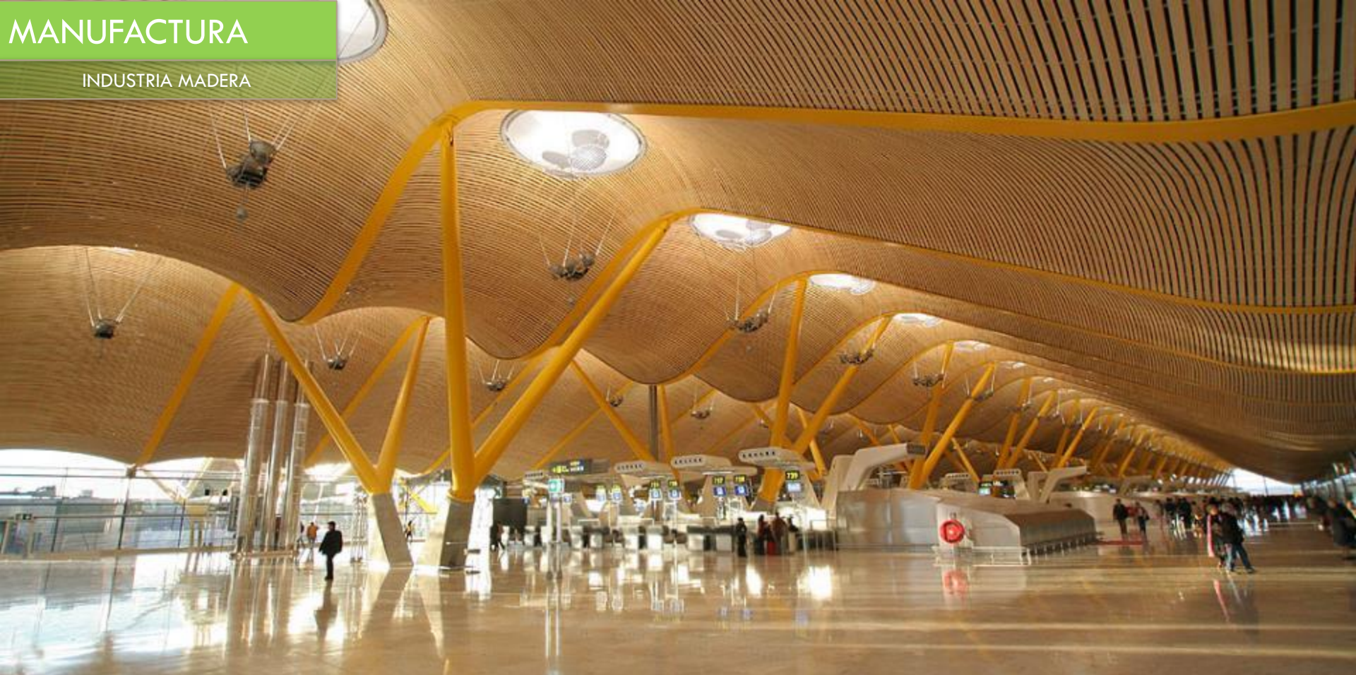
techado de bambú en la Terminal T4 de Barajas, Aeropuerto de Madrid
